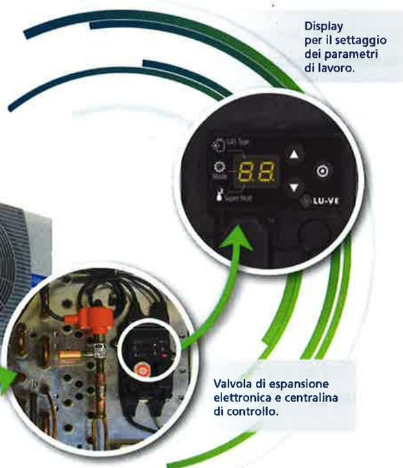
Display per il settaggio dei parametri di lavoro.
